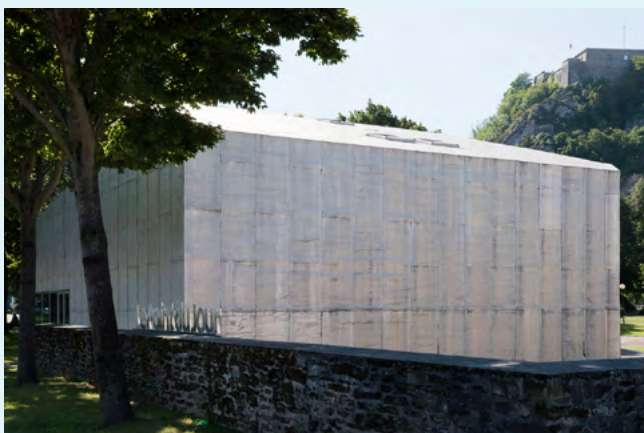
Le Point du Jour, vue des façades nord et ouest, 2018 Photographie : Camille Fallet
